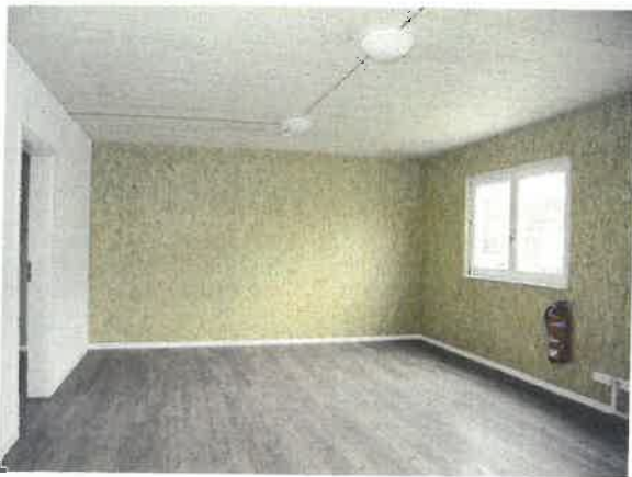
Der fertig gestellte Aufenthaltsraum mit Linoleumboden. Für den Brandschutz sorgt eine Brandmeldeanlage
