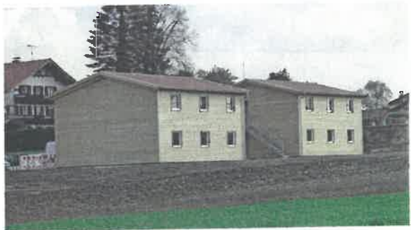
Zwei der Flüchtlingsheime in Stephanskirchen erhielten eine Wasserschlagschalung aus Fichtenholz
