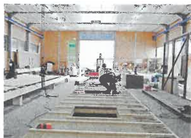
▶ In der Werkstatt von Holzbau Wörndl wurden die Wände der Häuser vorgefertigt, was den zügigen Bau vor Ort ermöglicht
