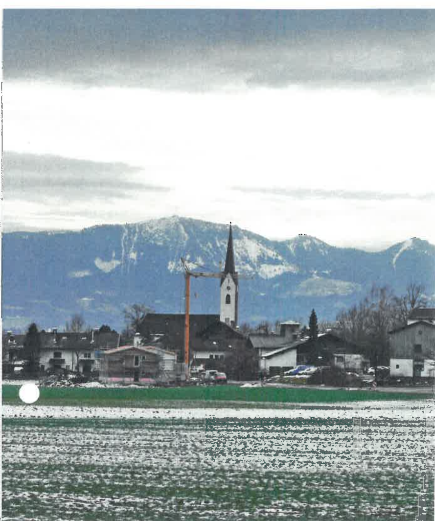
▲ In nur drei Tagen stand das neue Haus in Holzrahmenkonstruktion in Stephanskirchen
